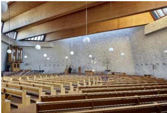
Christi Auferstehung, Memmingen (1970–1975), Arch. Hans Kammerer und Walter Belz, Stuttgart, Deckensystem aus Leimbindern
